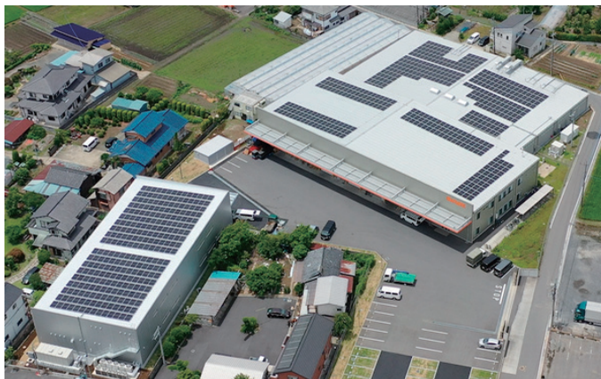
手前左下が(株)クラフトワーク第2工場。奥は(株)クラフトワーク本社工場
