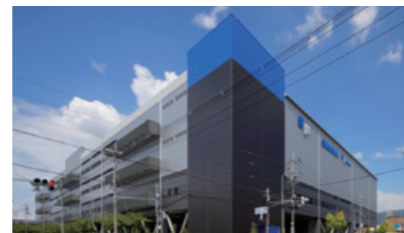
ハピネット東大阪ロジスティクスセンター (大阪府東大阪市)
