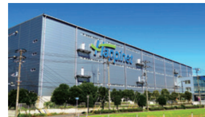
ハピネット市川ロジスティクスセンター (千葉県市川市)
