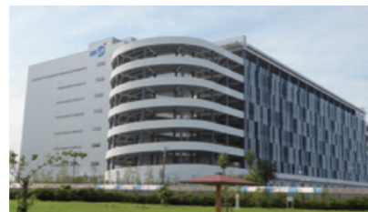
ハピネット船橋ロジスティクスセンター (千葉県船橋市)
