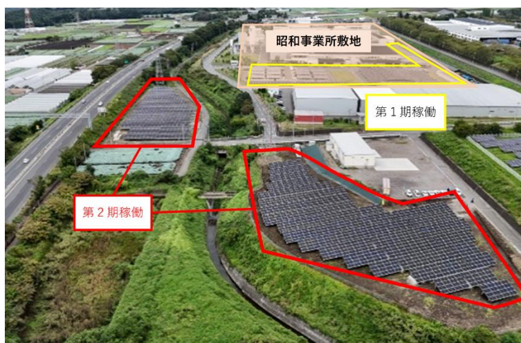
昭和业务所の太陽光パネル発電設備設置エリア
