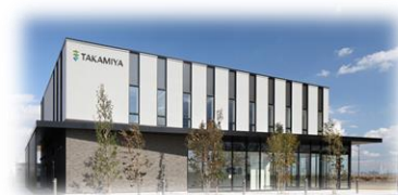
Takamiya Lab. West 兵庫県尼崎市
