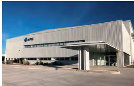
JFE Shoji Steel Service Center Bajío 本社工場 (メキシコ)
