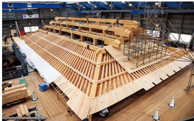
木軸建て方工事の様子
