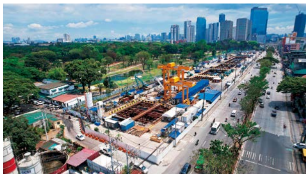
当社JVで施工中のノースアベニュー駅
