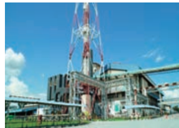
ジョホールバル工場(マレーシア)
