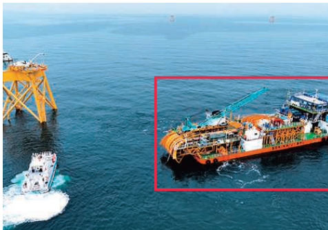
風車の基礎部分への海底ケーブルの布設
