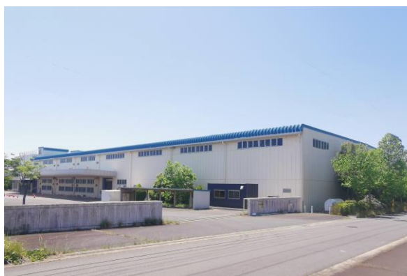
茨城工場外観
