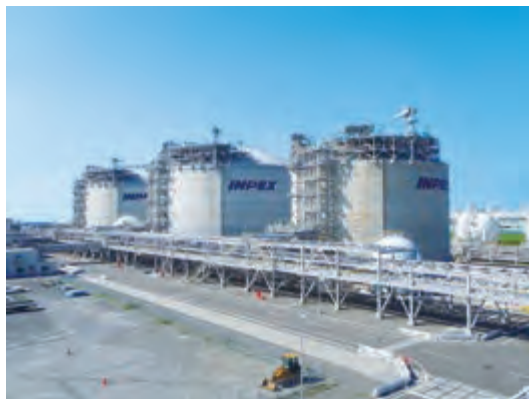
直江津LNG基地
