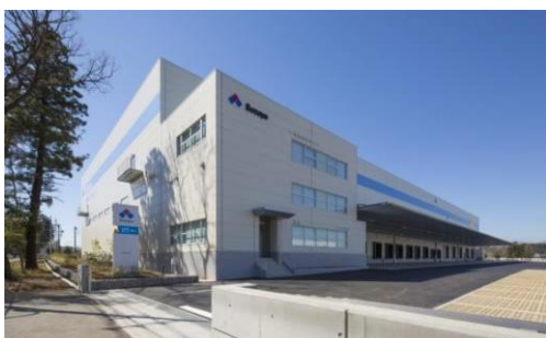
3 ロジスクエア日高 2015年3月竣工
