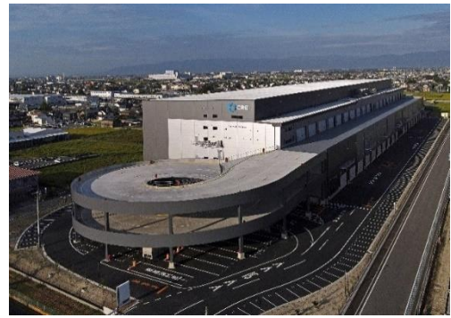
26 ロジスクエアー宮 2023年9月竣工
