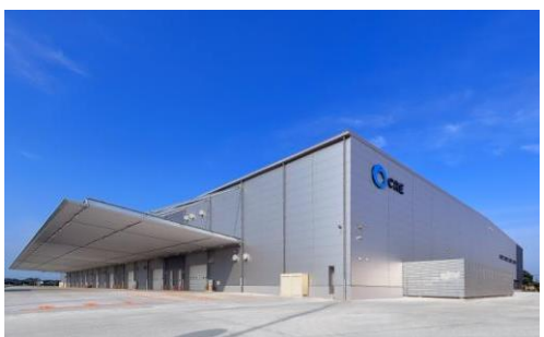
5 ロジスクエア羽生 2016年7月竣工
