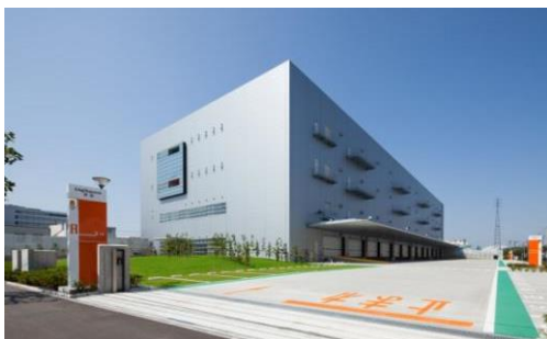
1 ロジスクエア草加 2013年6月竣工
