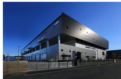
22 ロジスクエア白井 2022年12月竣工
