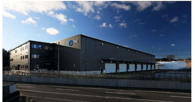
28 ロジスクエア掛川 2024年1月竣工
