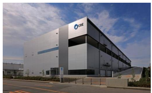
4 ロジスクエア久喜 2016年6月竣工
