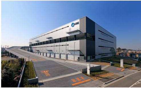
7 ロジスクエア浦和美園 2017年4月竣工
