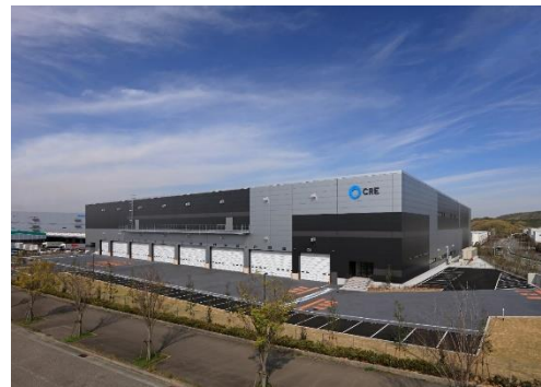
16 ロジスクエア神戸西 2020年4月竣工
