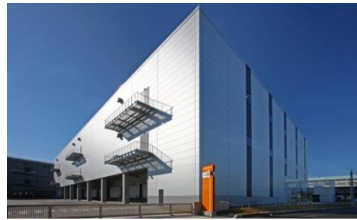
2 ロジスクエア八潮 2014年1月竣工
