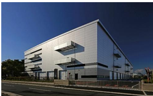
21 ロジスクエア伊丹 2022年11月竣工
