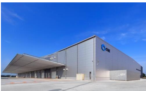
5 ロジスクエア羽生 2016年7月竣工
