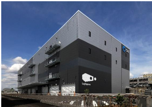
25 ロジスクエア松戸 2023年5月竣工
