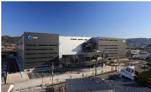
19 ロジスクエア大阪交野 2021年1月竣工
