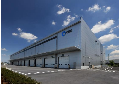
15 ロジスクエア川越Ⅱ 2019年6月竣工
