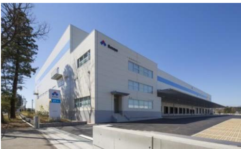
3 ロジスクエア日高 2015年3月竣工
