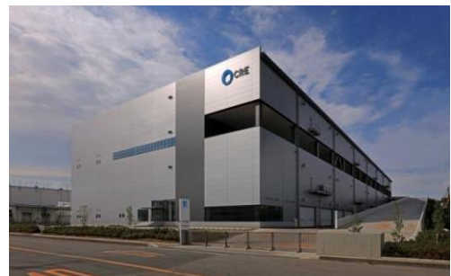
4 ロジスクエア久喜 2016年6月竣工
