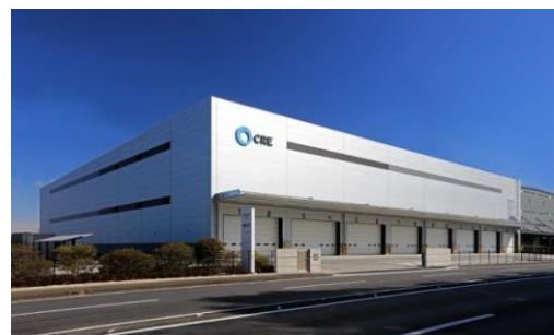
6 ロジスクエア久喜Ⅱ 2017年2月竣工
