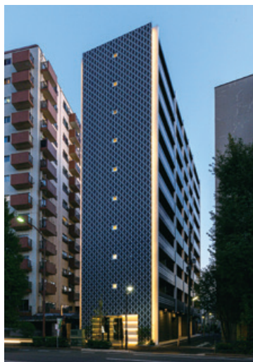
建物の外壁照明構造
