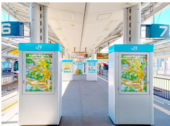
<JR 高松駅 電照式サインボード設置写真>
