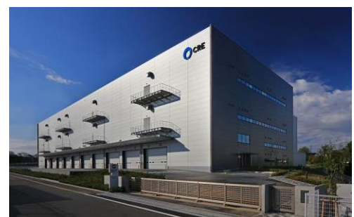
8 ロジスクエア新座 2017年4月竣工
