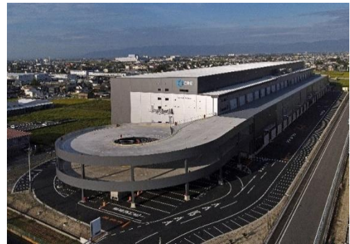
26 ロジスクエア一宮 2023年9月竣工
