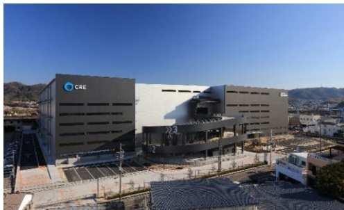
19 ロジスクエア大阪交野 2021年1月竣工
