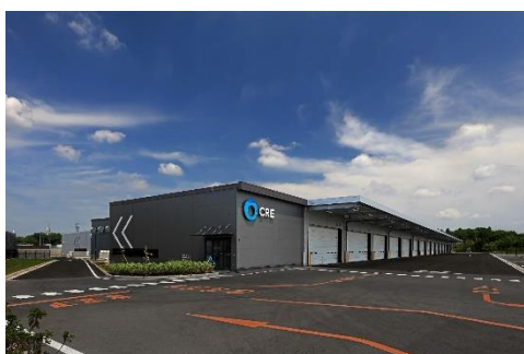
31 ロジスクエア成田 2024年5月竣工
