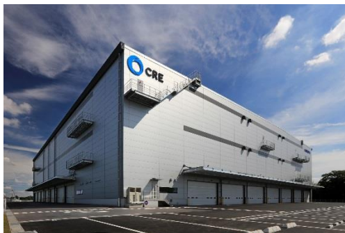
13 ロジスクエア春日部 2018年6月竣工
