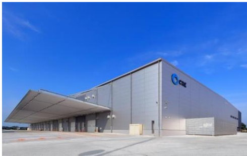
5 ロジスクエア羽生 2016年7月竣工
