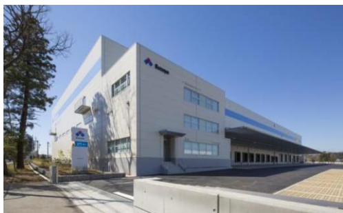
3 ロジスクエア日高 2015年3月竣工
