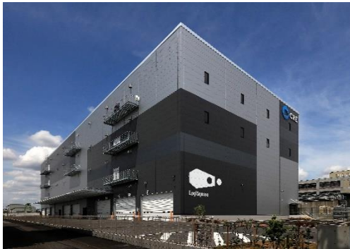
25 ロジスクエア松戸 2023年5月竣工
